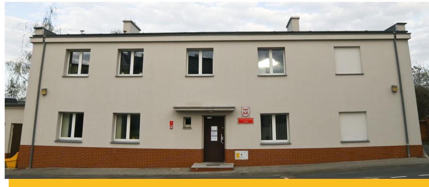
ul. Mickiewicza 17 budynek w podwórze
