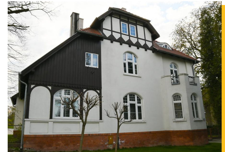
ul. Mickiewicza 46 Ośrodek Dokumentacji Geodezyjnej i Kartograficznej
