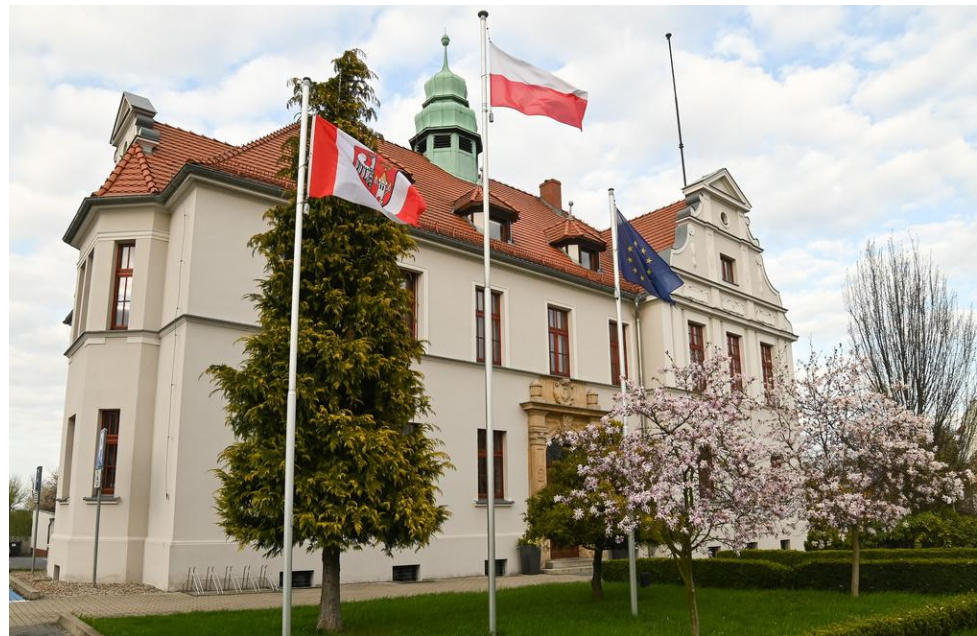
ul. Mickiewicza 17 budynek główny
