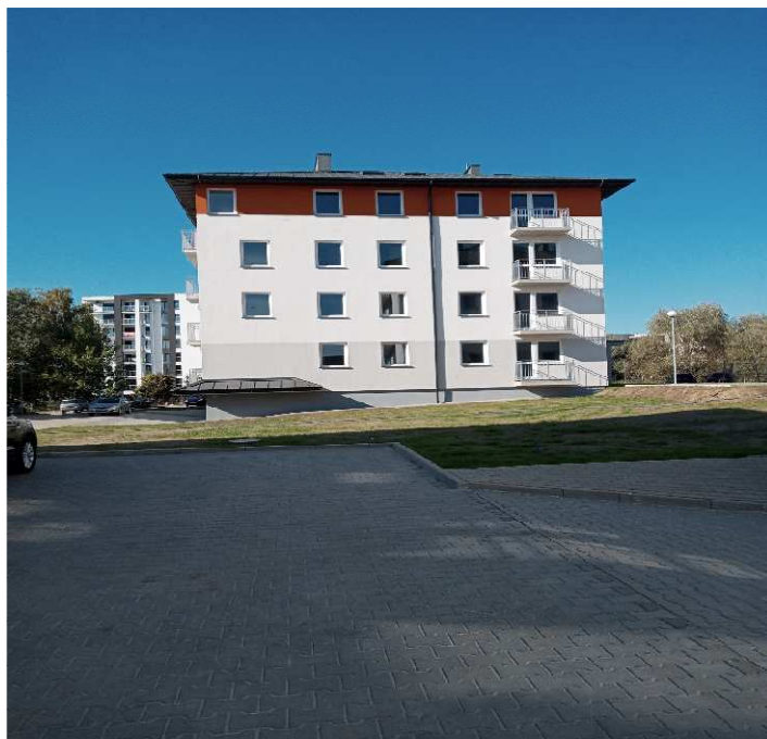
Rys. 2. Budynek mieszkaniowy wielorodzinny
