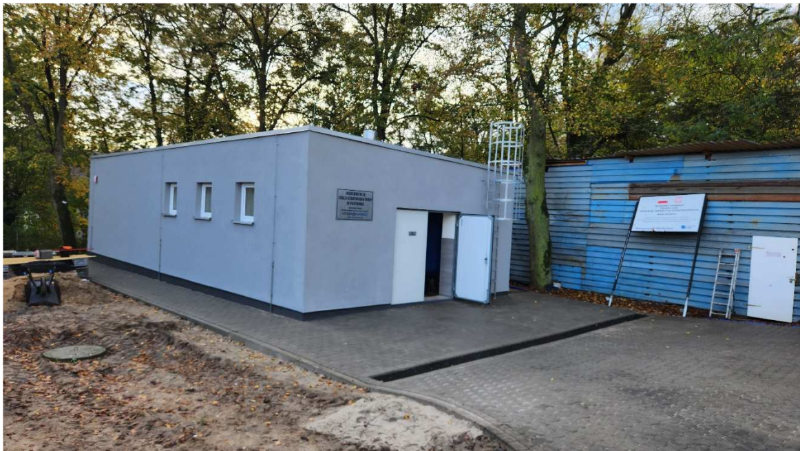
Stacja uzdatniania wody w Piotrowie gm. Brodnica
