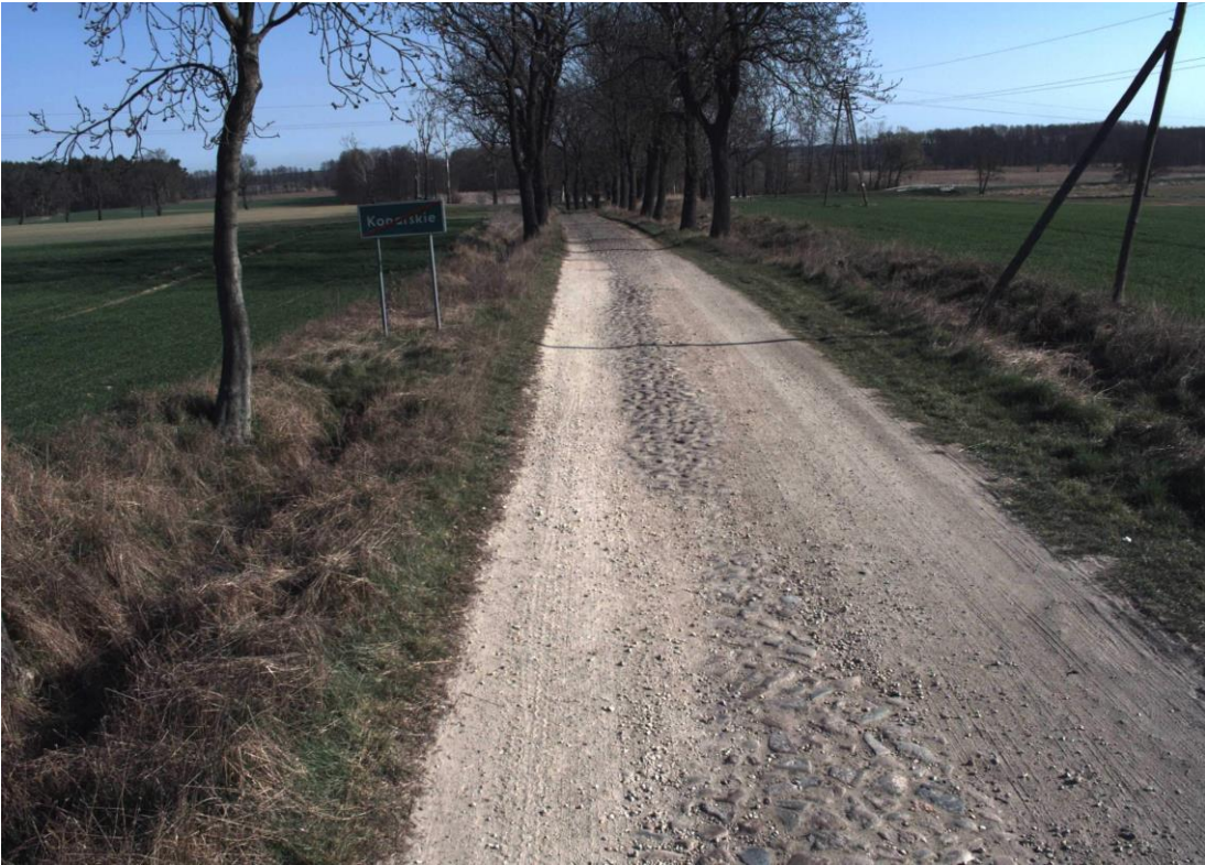
Droga powiatowa nr 4070P na odcinku Jarosławki – Konarskie przed modernizacją
