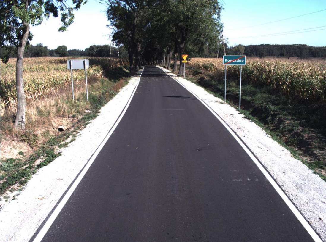
Droga powiatowa nr 4070P na odcinku Jarosławki – Konarskie po modernizacji
